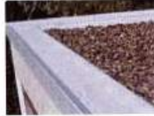
Flachdach mit Kiesfüllung
